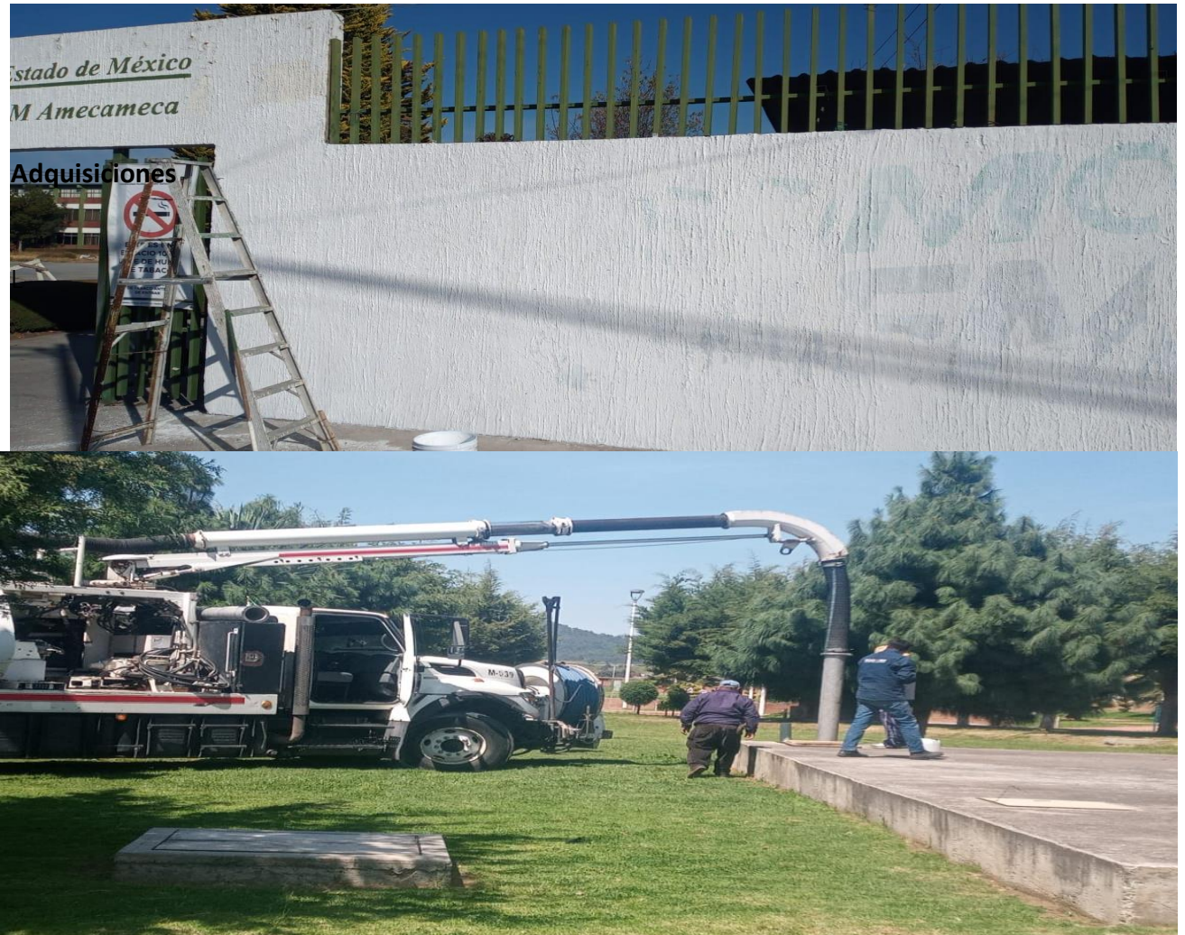
Fotografía No. 8 Collage de los servicios de mantenimiento en 2022 del C.U. Amecameca
