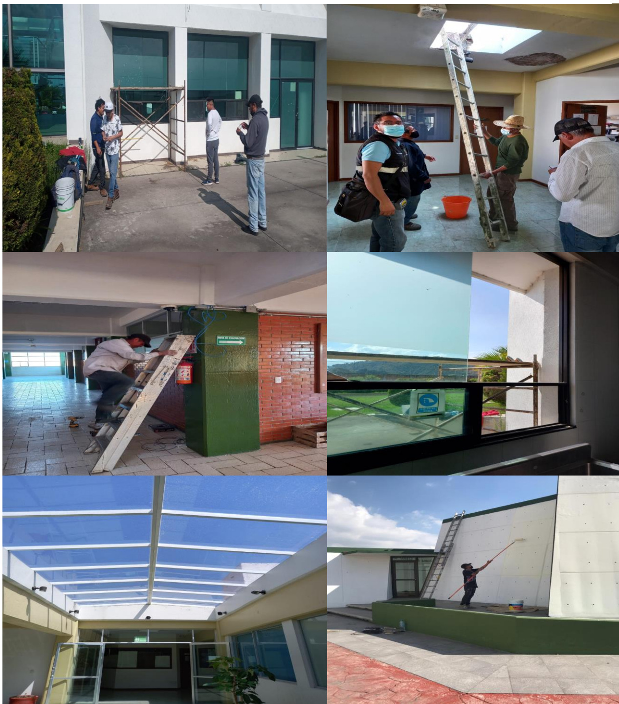
Fotografía No. 7 Collage de imágenes de la reparación de daños en edificios del C.U. Amecameca 2022
