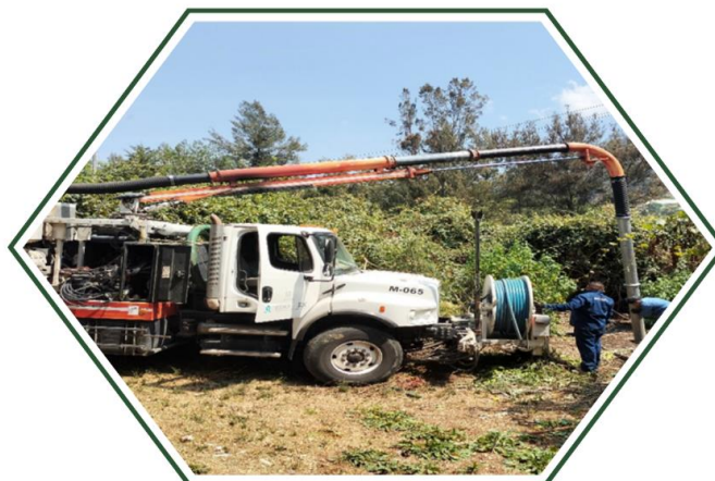
Desazolve de fosas sépticas del CUT.
