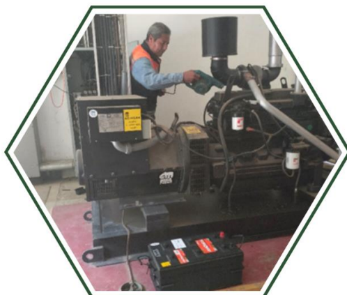
Mantenimiento a las Plantas de Luz del Centro Universitario UEM Tenancingo.
