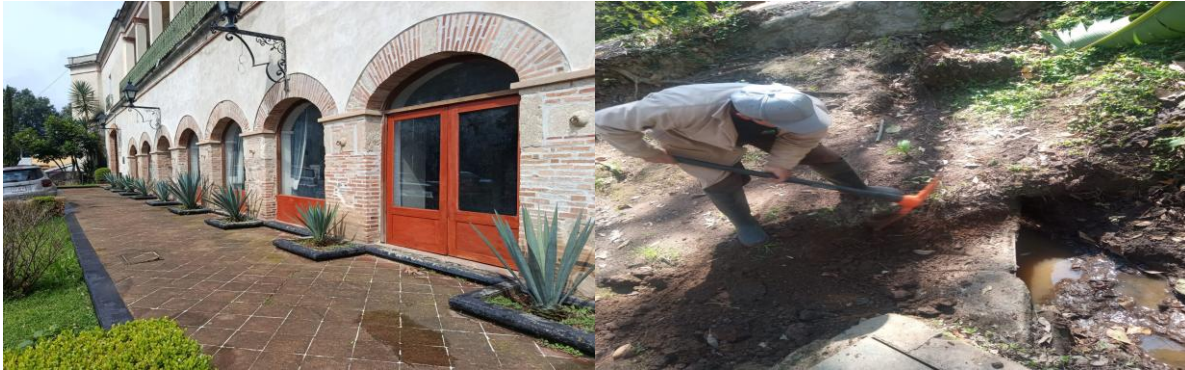
Mantenimiento a arcos del casco planta baja y al registro de agua del pozo principal. Año, 2026.
