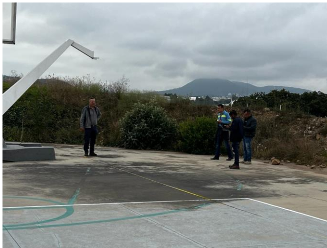
Imagen 115. Arco techo cancha de Basquetbol
