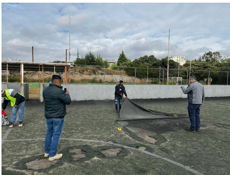
Imagen 114. Reacondicionamiento canchas de Futbol rápido
