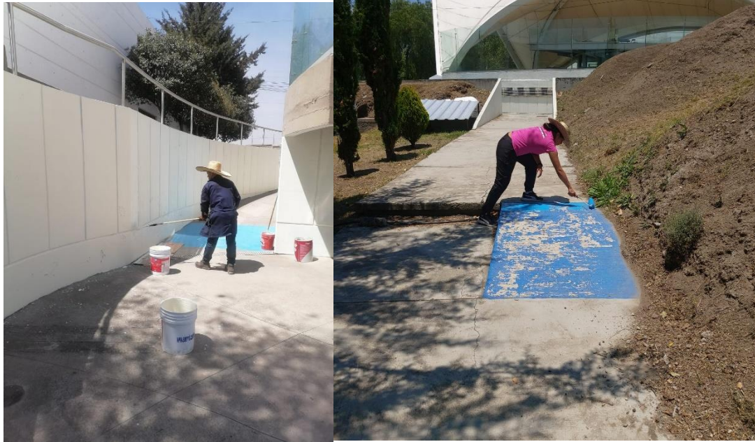
Imagen 119. Pintura en muros y rampas
