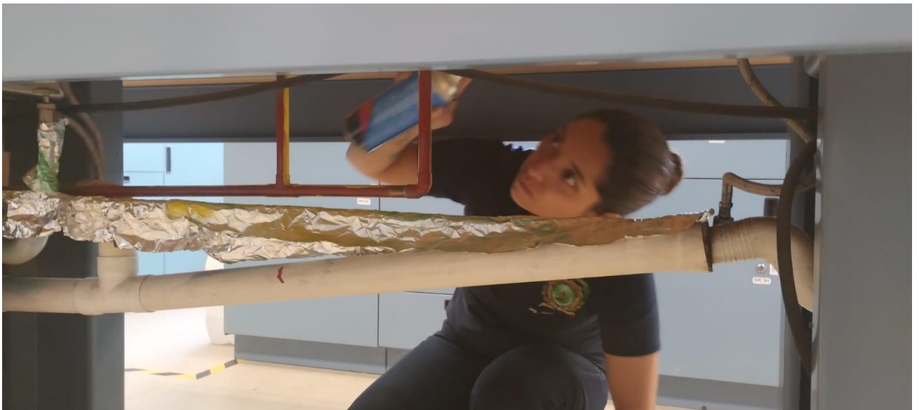
Imagen 134. Señalizando tubería de gas
