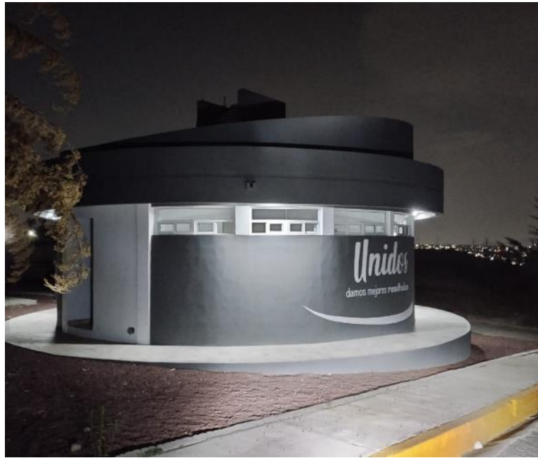
Imagen 99. Módulo de vestidores y baños área deportiva
