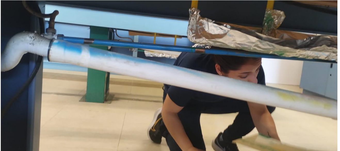
Imagen 133. Señalizando tuberías hidráulicas
