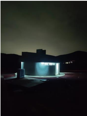
Imagen 130. Modulo de vestidores y baños área de canchas deportivas
