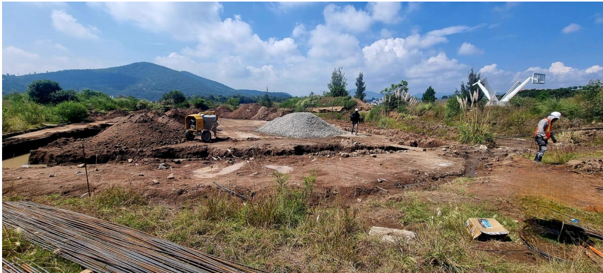
Imagen 50: Inicios de obra
