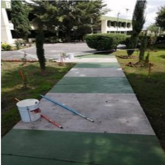
Pintura en pasillo principal
