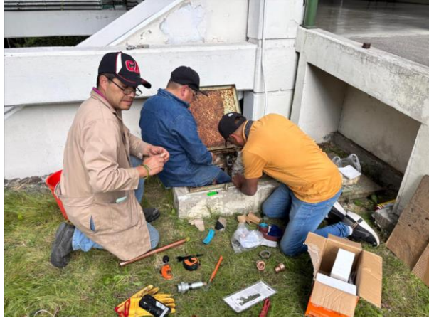
Ilustración 5.1 "Mantenimiento a bomba de agua" Fuente: UAEMEX, Facultad de Ingeniería, 2026.
