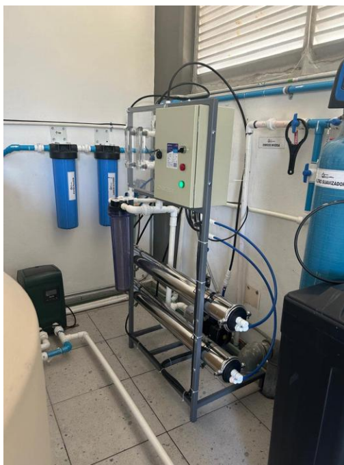
Imagen 17. Renovación del Sistema de Osmosis Inversa.
