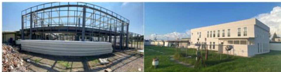
Figura 7. Remodelación y ampliación del Laboratorio de Calidad del Agua
