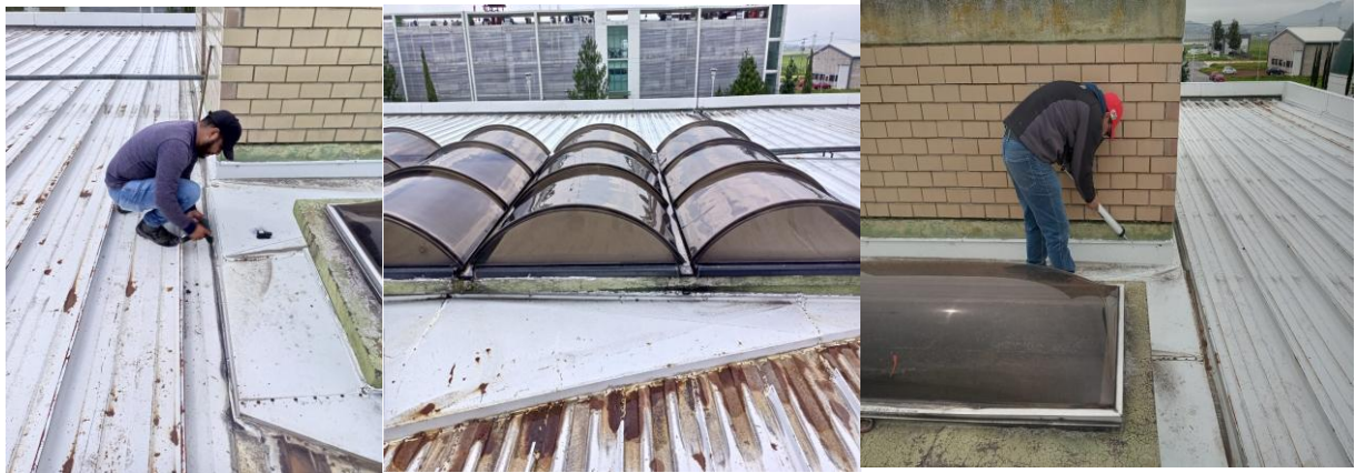
Figura 0.4 Mantenimiento edificio D
