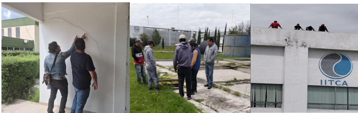
Figura 0.6 Inspección por parte de la Dirección de Obra Universitaria
