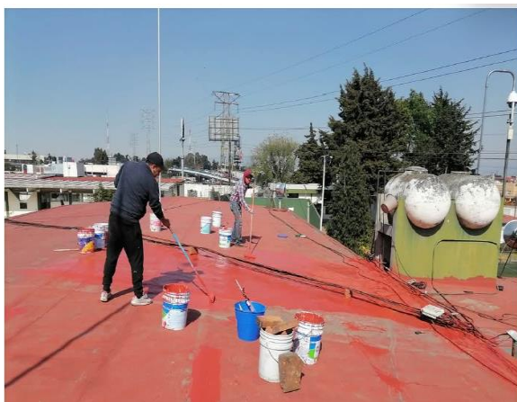
Imagen 55. Impermeabilización del edificio administrativo.
