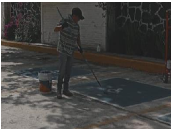
Imagen 54. Repintado de señalización.
