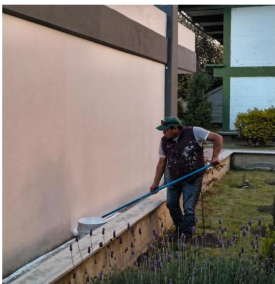
Imagen 39. Mantenimiento preventivo y correctivo de instalaciones.
