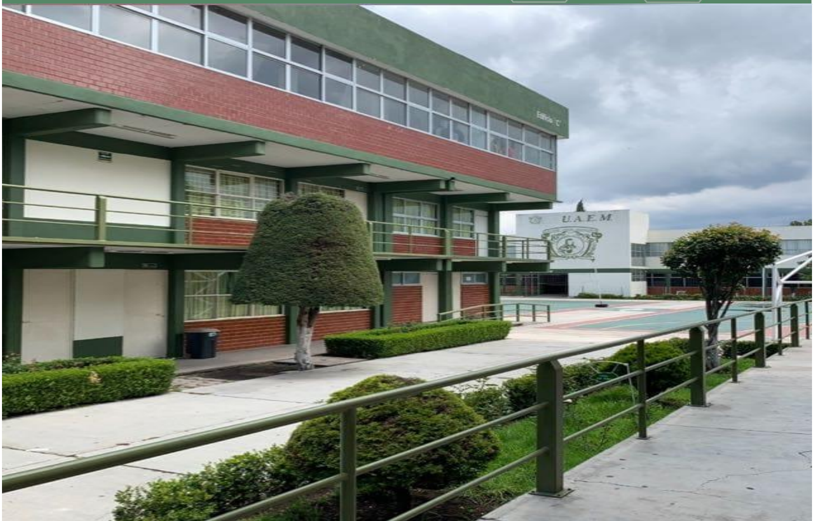
Edificio C del Plantel Sor Juana Inés de la Cruz
