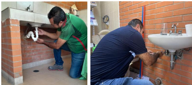
Imagen 78. Acciones de mantenimiento preventivo y correctivo en instalaciones hidráulicas.
