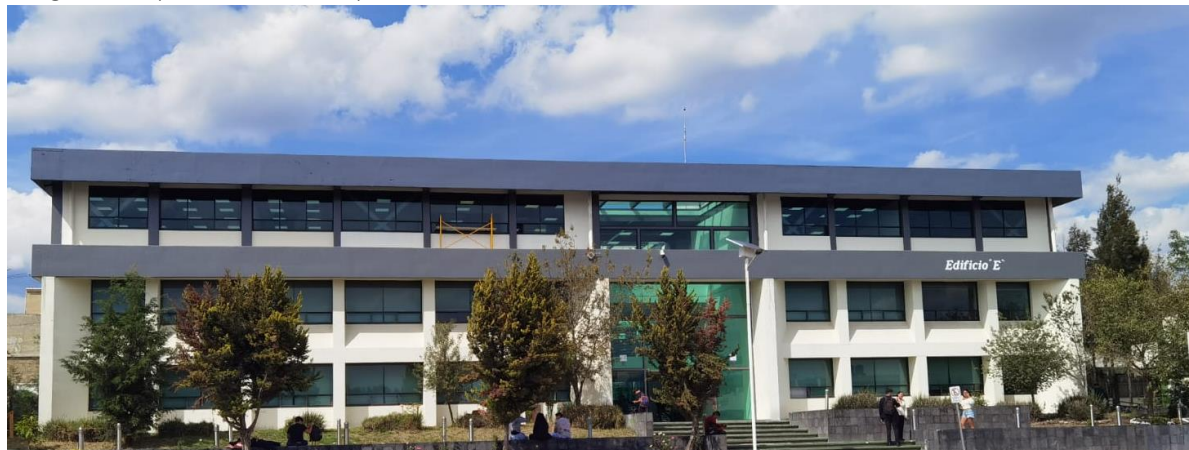
Imagen 3. Ampliación del tercer piso del edificio “E”, UAPCI, UAEMEX, 2023
