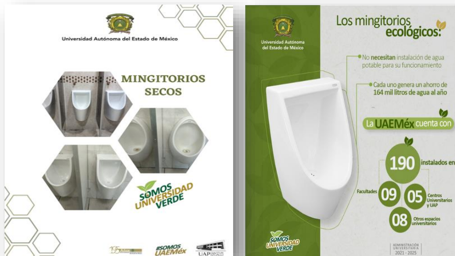
Imagen 48. Colocación de mingitorios secos , UAPCI, UAEMEX, 2023
