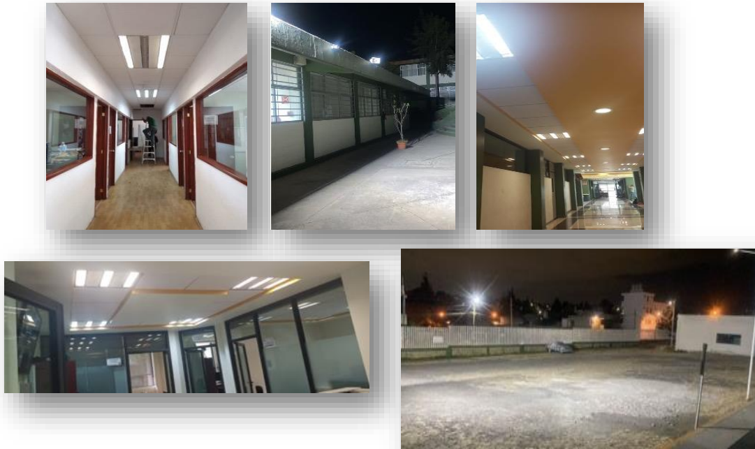
Imagen 51. Mejoramiento de la Infraestructura de la UAPCI, UAEMEX, 2023
