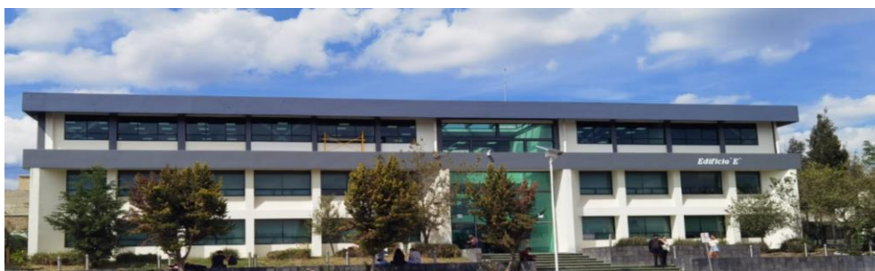
Imagen 3. Ampliación del tercer piso del edificio “E”, UAPCI, UAEMéx, 2024
