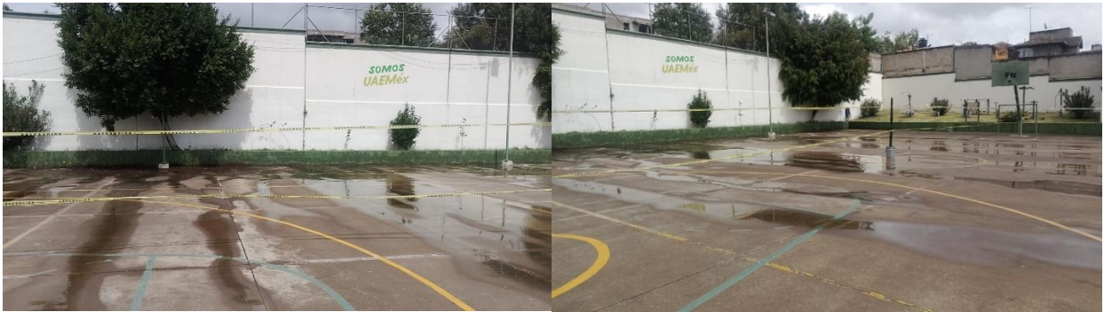
Imagen 55. Revisión y Corrección de la Barda Perimetral, UAPCI, UAEMéx,2024
